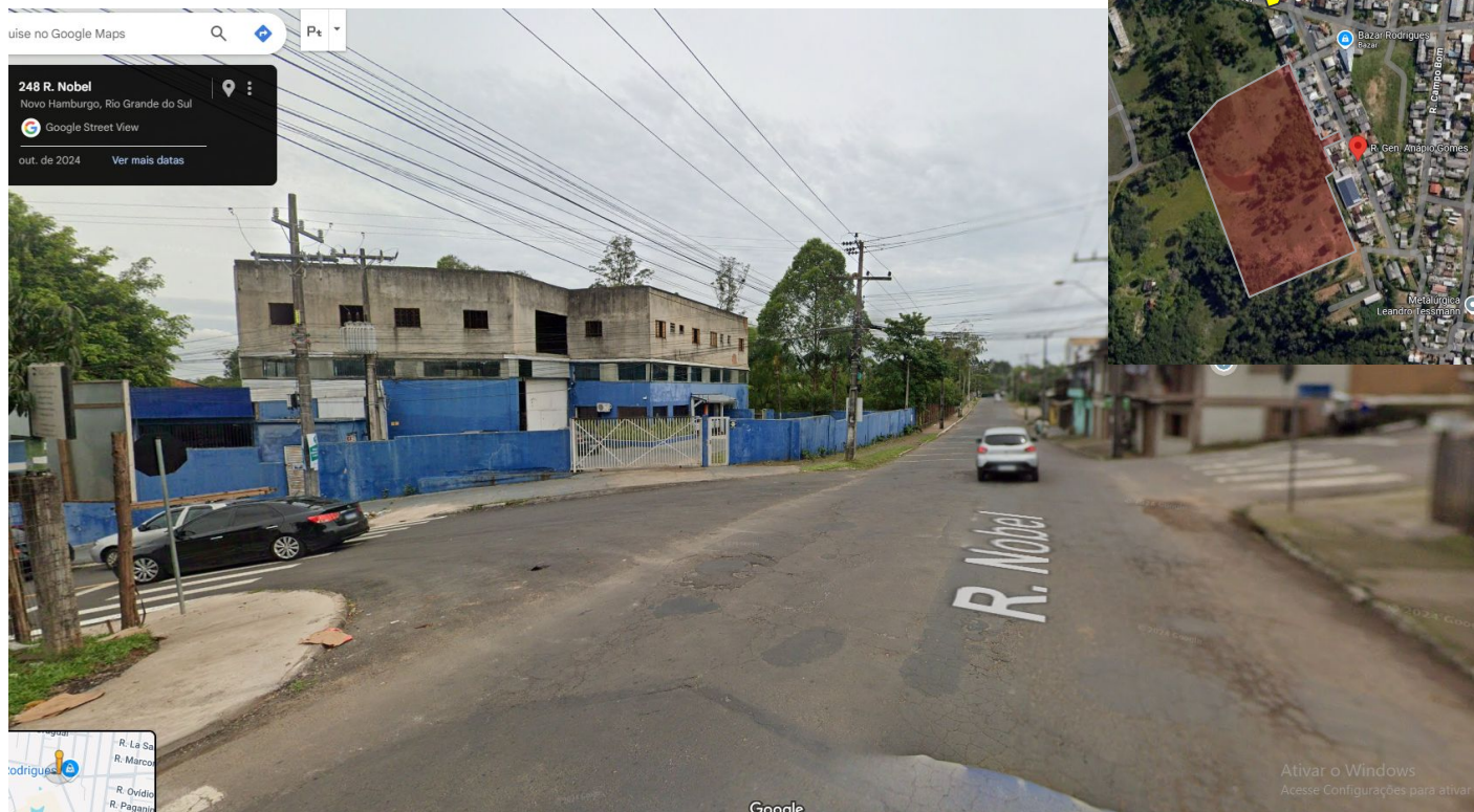
Rua Nobel, interseção com Rua General Anápio Gomes
