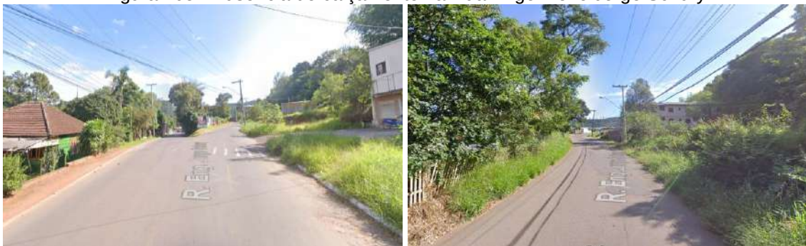
Figura 165 - Ausência de calçamento na Rua Engenheiro Jorge Schury
