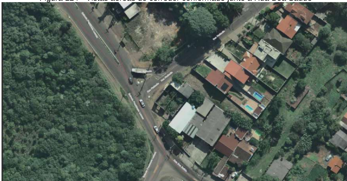
Figura 124 - Vistas aéreas do corredor conformado junto a Rua Boa Saúde
