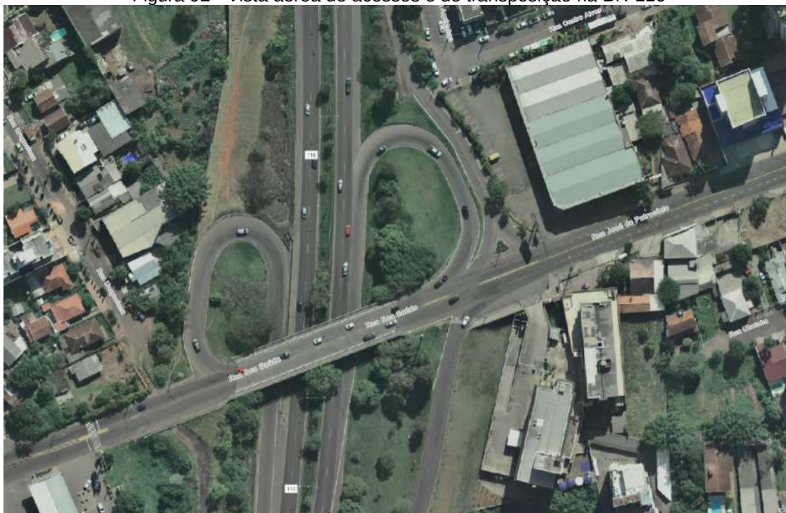
Figura 92 - Vista aérea de acessos e de transposição na BR-116
