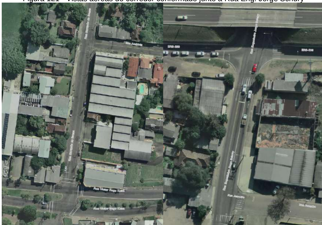
Figura 121 - Vistas aéreas do corredor conformado junto a Rua Eng. Jorge Schury
