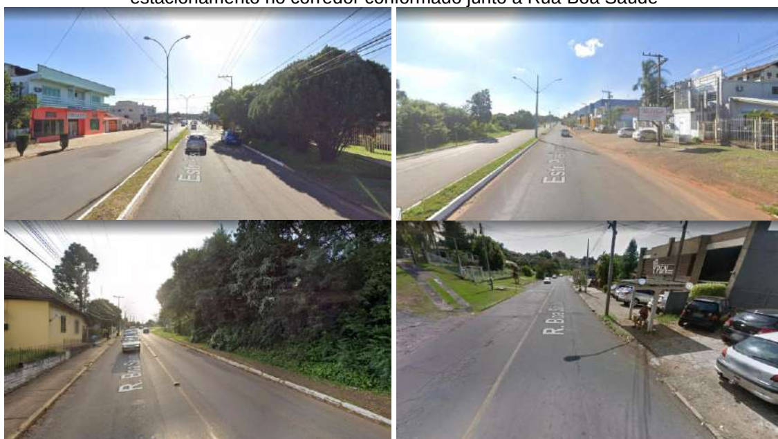
Figura 125 – Pistas de rolamento, ponto de ônibus, detalhe da sinalização e conflitos de estacionamento no corredor conformado junto a Rua Boa Saúde
