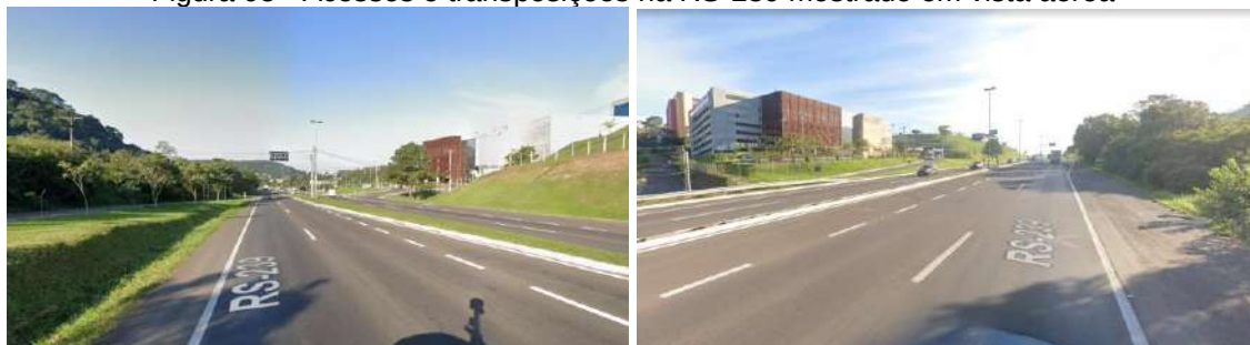
Figura 95 - Acessos e transposições na RS-239 mostrado em vista aérea
