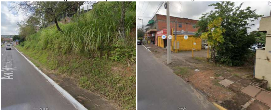
Figura 149 - Calçamento na Avenida Victor Hugo Kunz
