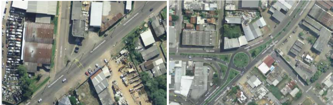
Figura 109 - Vistas aéreas do corredor conformado junto a Rua Bartolomeu de Gusmão
