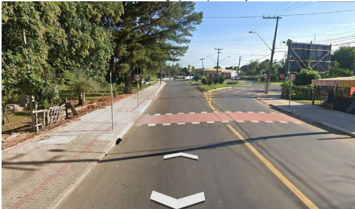
Figura 178 - Trecho de calçada com trânsito compartilhado entre pedestres e ciclistas na Estrada da Integração Leopoldo Petry
