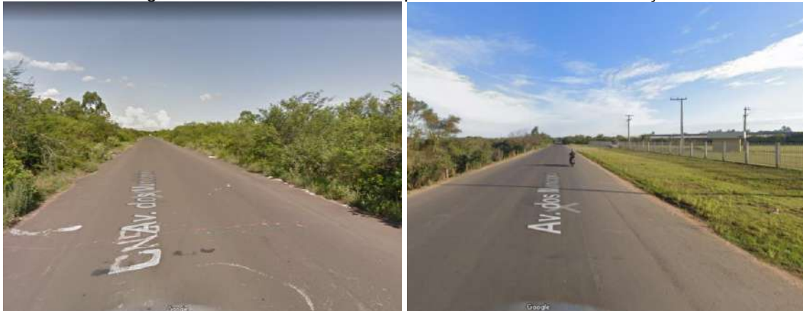
Figura 147 - Avenida dos Municípios em trechos sem sinalização
