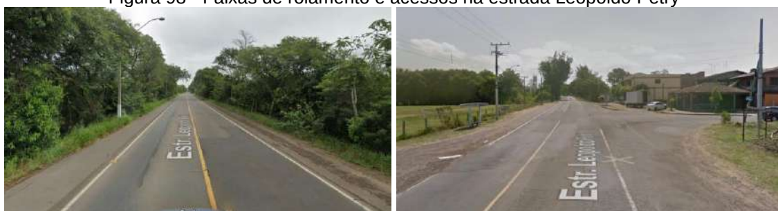
Figura 98 - Faixas de rolamento e acessos na estrada Leopoldo Petry
