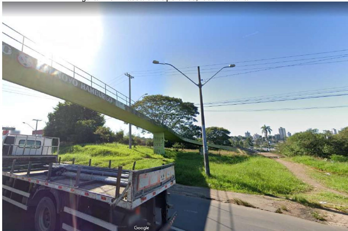
Figura 143 - Passarela Operários, localizada na BR-116
