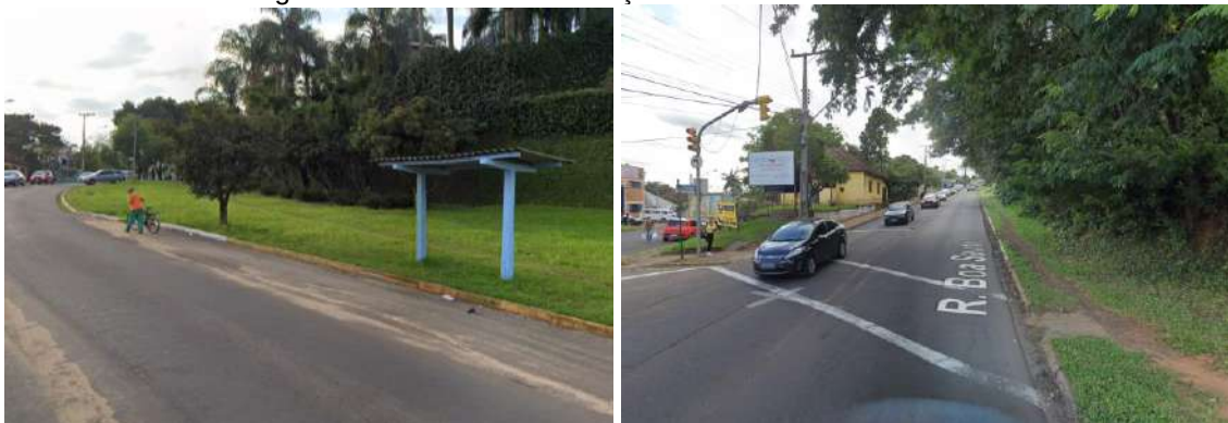
Figura 167 - Ausência de calçamento na Rua Boa Saúde
