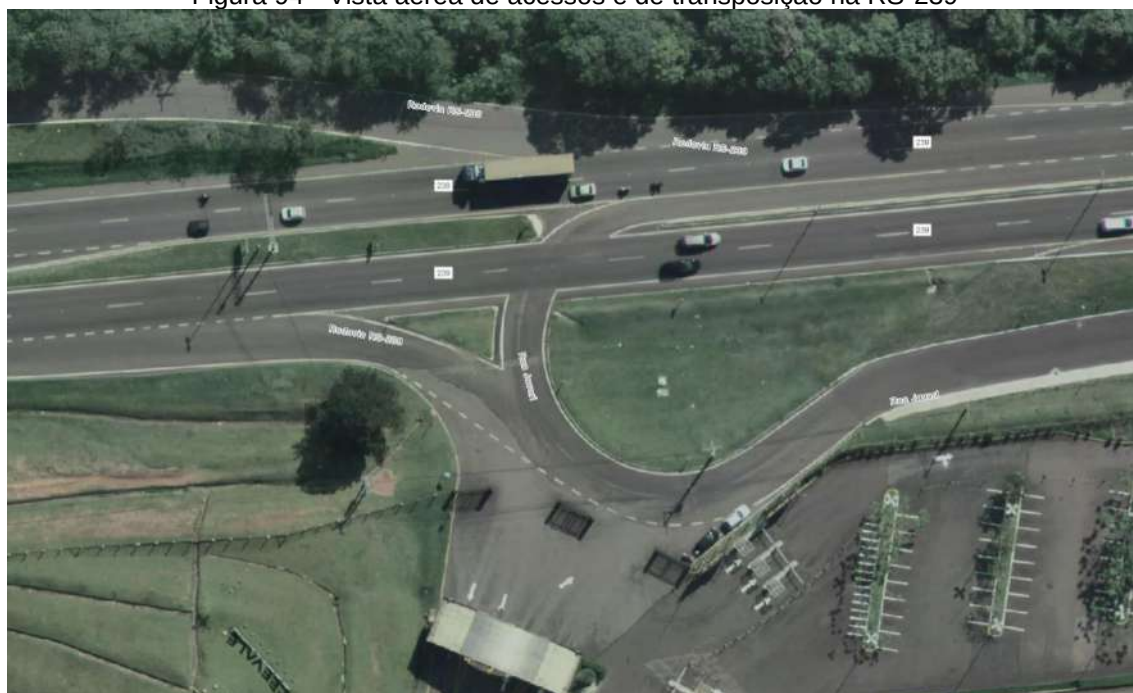
Figura 94 - Vista aérea de acessos e de transposição na RS-239
