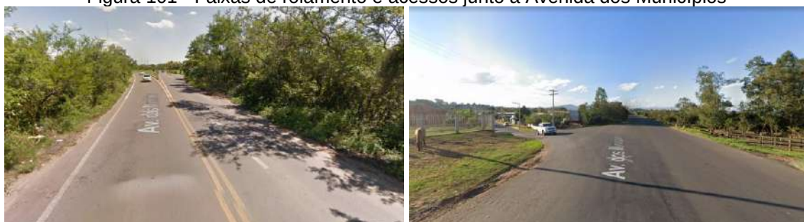
Figura 101 - Faixas de rolamento e acessos junto a Avenida dos Municípios
