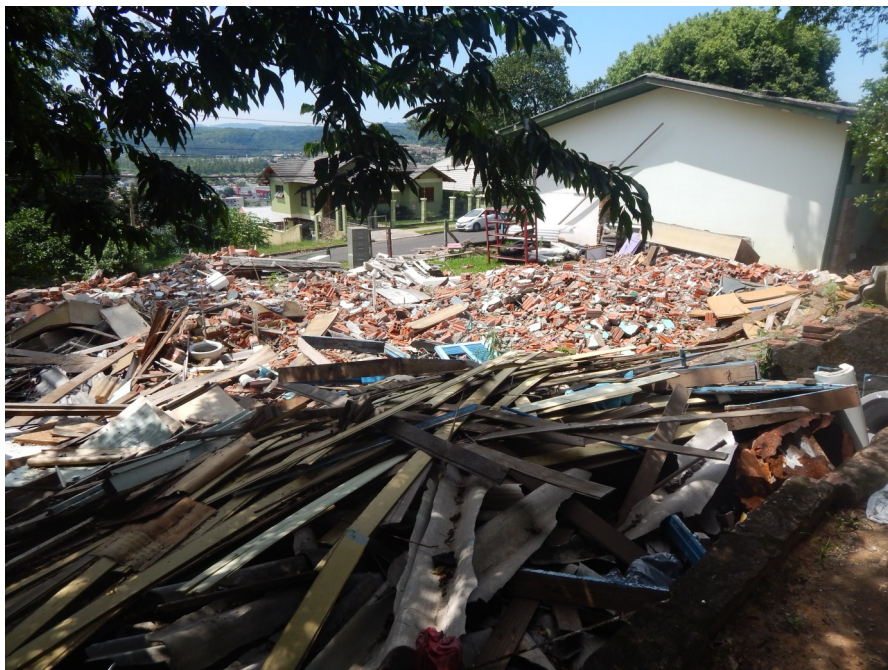
Figura 1: Entulhos da Demolição
