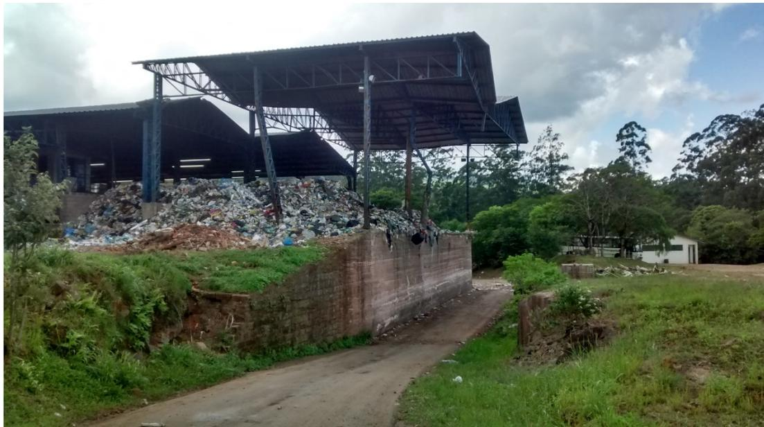
Toda a Estação de Transbordo é coberta por estrutura metálica, contudo, uma parte dos pilares está danificada, oferecendo risco aos funcionários que trabalham no local. Não foi identificado sistema de drenagem pluvial tanto na área de transbordo quanto na de recepção dos resíduos, havendo possibilidade de contaminação do solo pelo lixiviado produzido pela decomposição da matéria orgânica. Verificou-se durante visita a presença de animais domésticos, aves e moscas no local.
