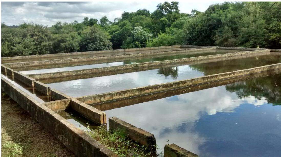
**Figura 39:** Sistema de tratamento do lixiviado.
